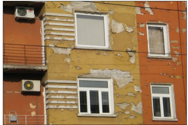
Слики 1.1.44: Ефекти од притисок на дифузна влага под фасадниот слој
