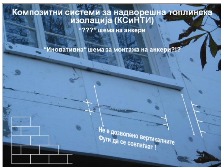
Слика 1.1.39: Произволен број на анкери и произволна шема на анкерисување, како и недозволено совпаѓање на вертикалните фуги меѓу ЕПС-плочите
