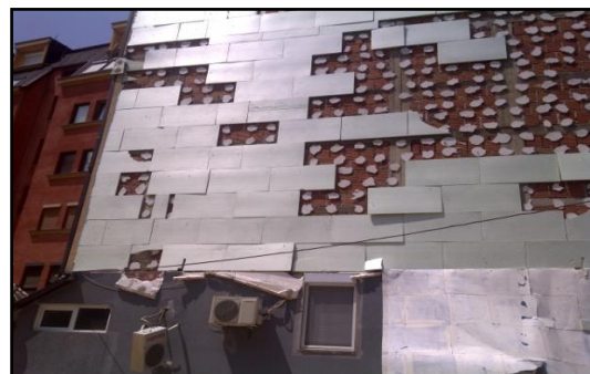
Слики 1.1.37: Отпаднати ЕПС-плочи поради некомпатибилност на лепилото и пластифициран малтер
