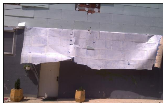
Слики 1.1.38: Лепење на стиропор-плочи со несоодветно лепило нанесено според произволна шема (лево) и монтирање стаклена мрежа врз стиропор без прв слој малтер (Извор: Т. Костадиновски)
