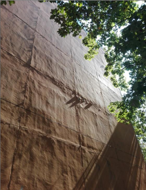
Слики 1.1.44: Ефекти од притисок на дифузна влага под фасадниот слој
