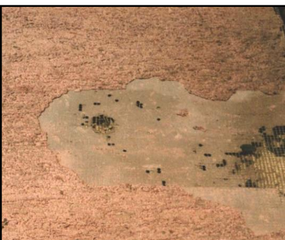
Слика 1.1.43: Одлепување на финален фасаден малтер од армираниот малтер
