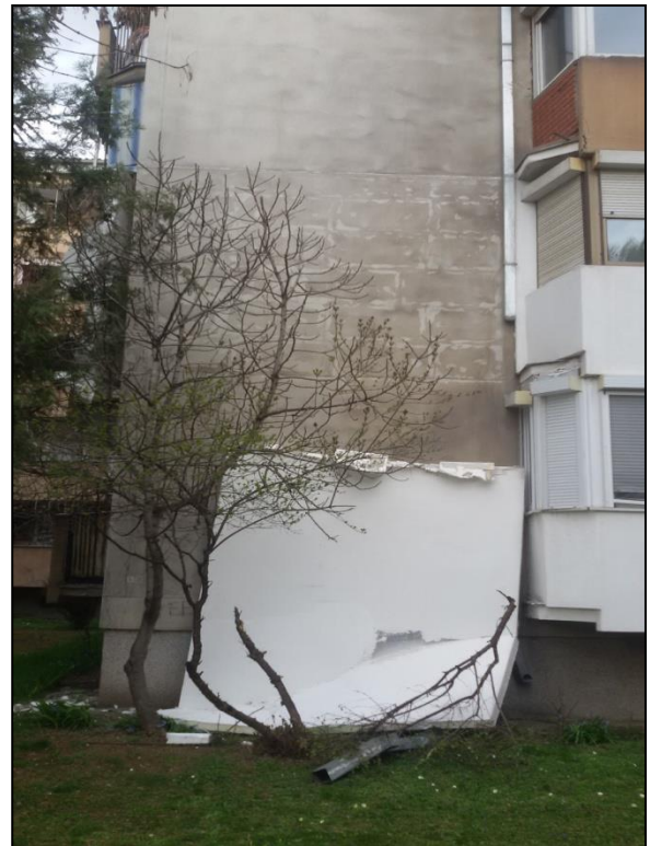
Слики 1.1.37: Отпаднати ЕПС-плочи поради некомпатибилност на лепилото и пластифициран малтер
