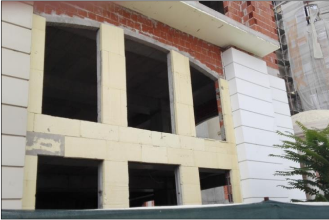
Слика 1.1.41: Незаштитен стиропор пожелтен од дејство на УВ зраци
