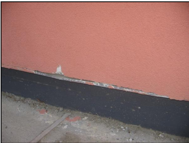
Слика 1.1.45: Дилатација на метален профил
