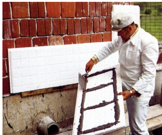
Слика 1.1.18: лепење на стиропор плочи
