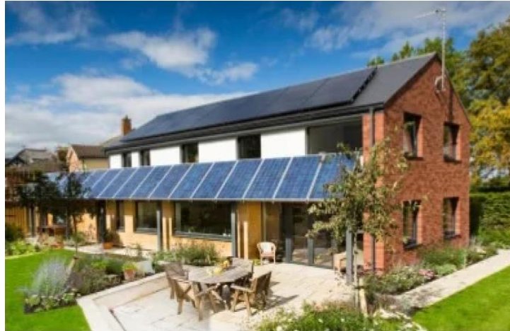
Слика 1. НЗЕБ концепт - зграда со комбинација од ПВ и Соларни термални колектори
