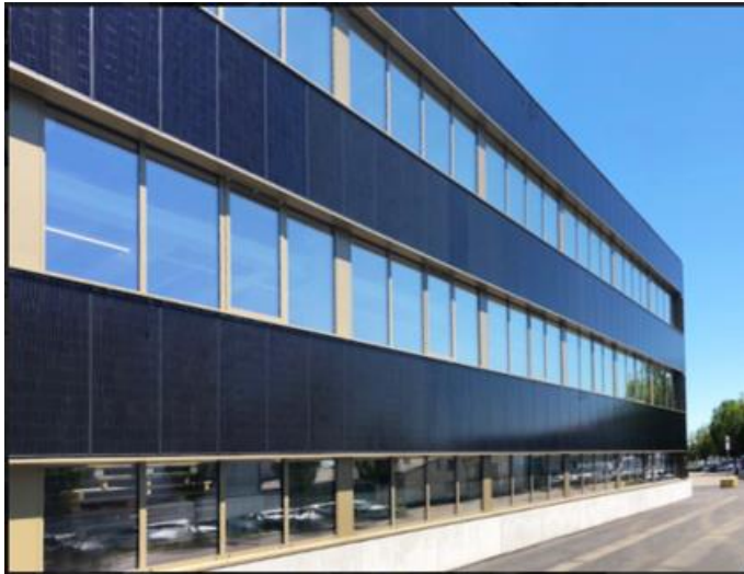
Слика 4. NZEB зграда со ПВ и ПВТ колектори на јужната фасада
